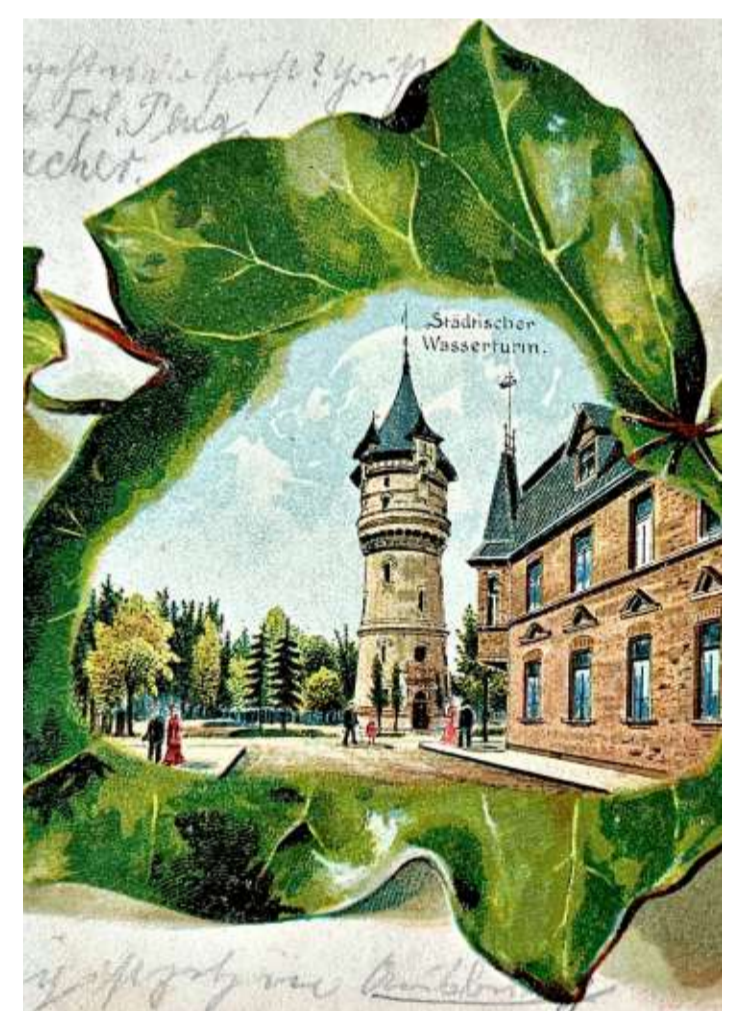
Der Wasserturm in Nienburg ist im Jahr 1903 in Betrieb genommen worden. Heute kümmert sich der Wasserturmverein um den Erhalt.
